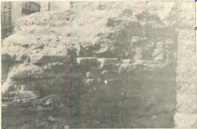
Фиг. 2. Фрагмент от западната крепостна стена на Сердика с нивелационен пласт
