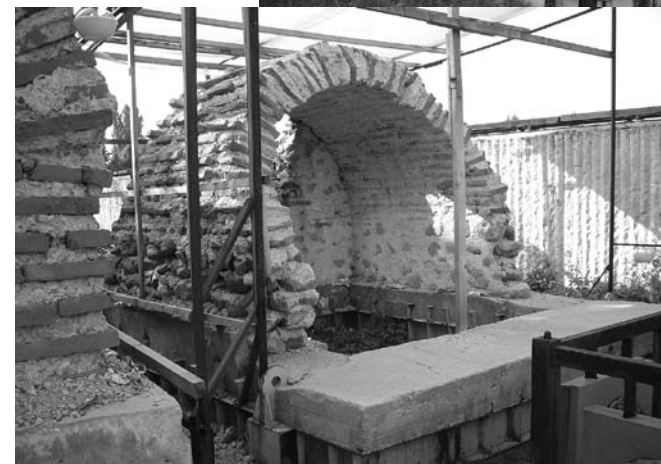
Обр. 10. Гробница I – укрепване и временно покритие
