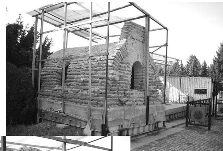
Обр. 9. Гробница III – укрепване и временно покритие
